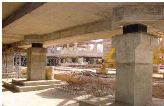
نمونه‌ای از کاربرد عایق لاستیکی (الاستومر) برای کاهش نیروی زلزله
