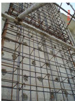
استفاده از دیوار برشی بتنی برای مقاوم‌سازی یک ساختمان مسکونی در شهرک غرب تهران-۱۳۸۳
