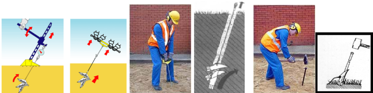
(شکل ۳-۲) کوبیدن داکبیل در زمین با پتک
