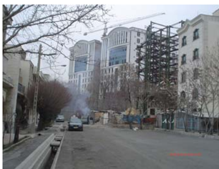
برجهای اسکلت بتنی که در سال ۱۳۸۲ مقاوم سازی شدند و در آن تلفیقی از دیوارهای برشی بتنی، میانقابهای مرکب و بتنی، و پلیمر الیافی بکار گرفته شد
