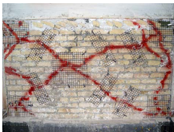
شکل ۶ نمایی از موقعیت نصب شبکه فلزی
