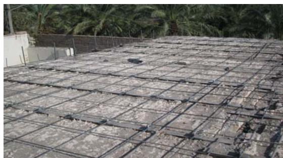
استفاده از سیستم دوخت و دوز برای مقاوم‌سازی ساختمانهای بچ
