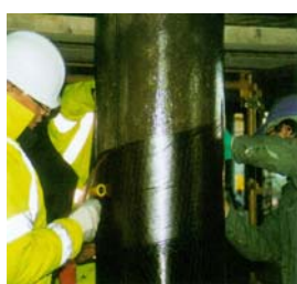
استفاده از پلیمر الیافی برای تقویت ستونها و تیرها
