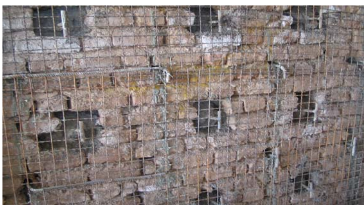
کاربرد پوشش بتنی برای تقویت ستون بتنی و دیوار آجری
