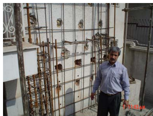
استفاده از دیوار برشی بتنی برای مقاوم‌سازی یک ساختمان مسکونی در شهرک غرب تهران-۱۳۸۳
