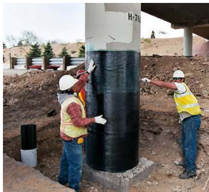
کاربرد پلیمر الیافی برای افزایش مقاومت و ظرفیت تغییر شکل پایه پلها
