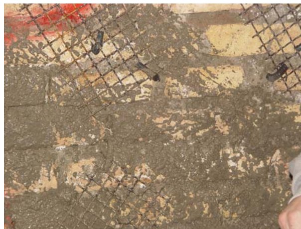
شکل ۷ نمایی از اجرای لایه اول سیمانکاری
