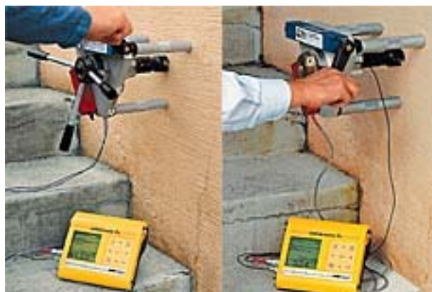
شکل (۱-۱۰): تجهیزات انجام آزمایش بیرون کشیدگی
