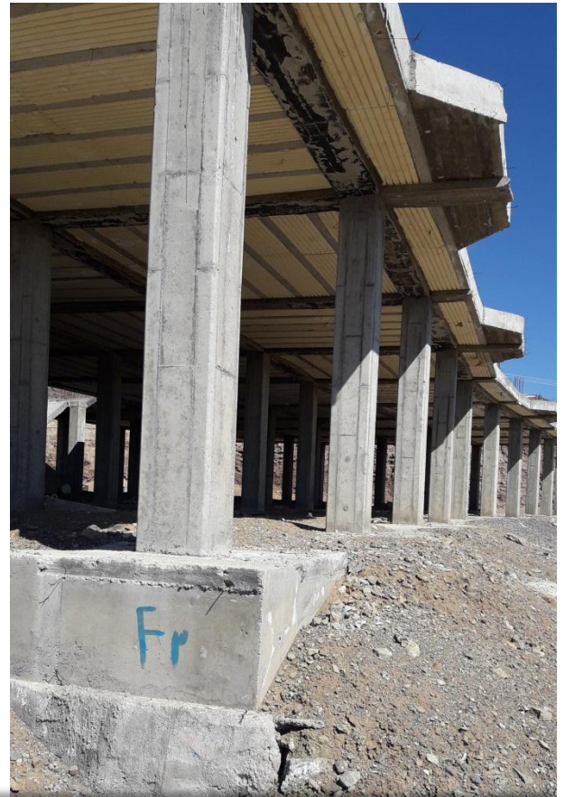
پروژهی مقاومتسازی ساختمانهای در حال ساخت بنیاد خیریه صدر هاشمی نژاد
