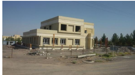
مقاوم سازی ساختمان فرهنگی شماره ۲ شهید بهشتی واقع در دانشگاه ولی عصر (عج)
